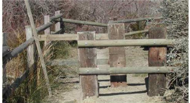
Exemple de chicane et barrière interdisant l'accès des véhicules – FEVRIER J., 2004
